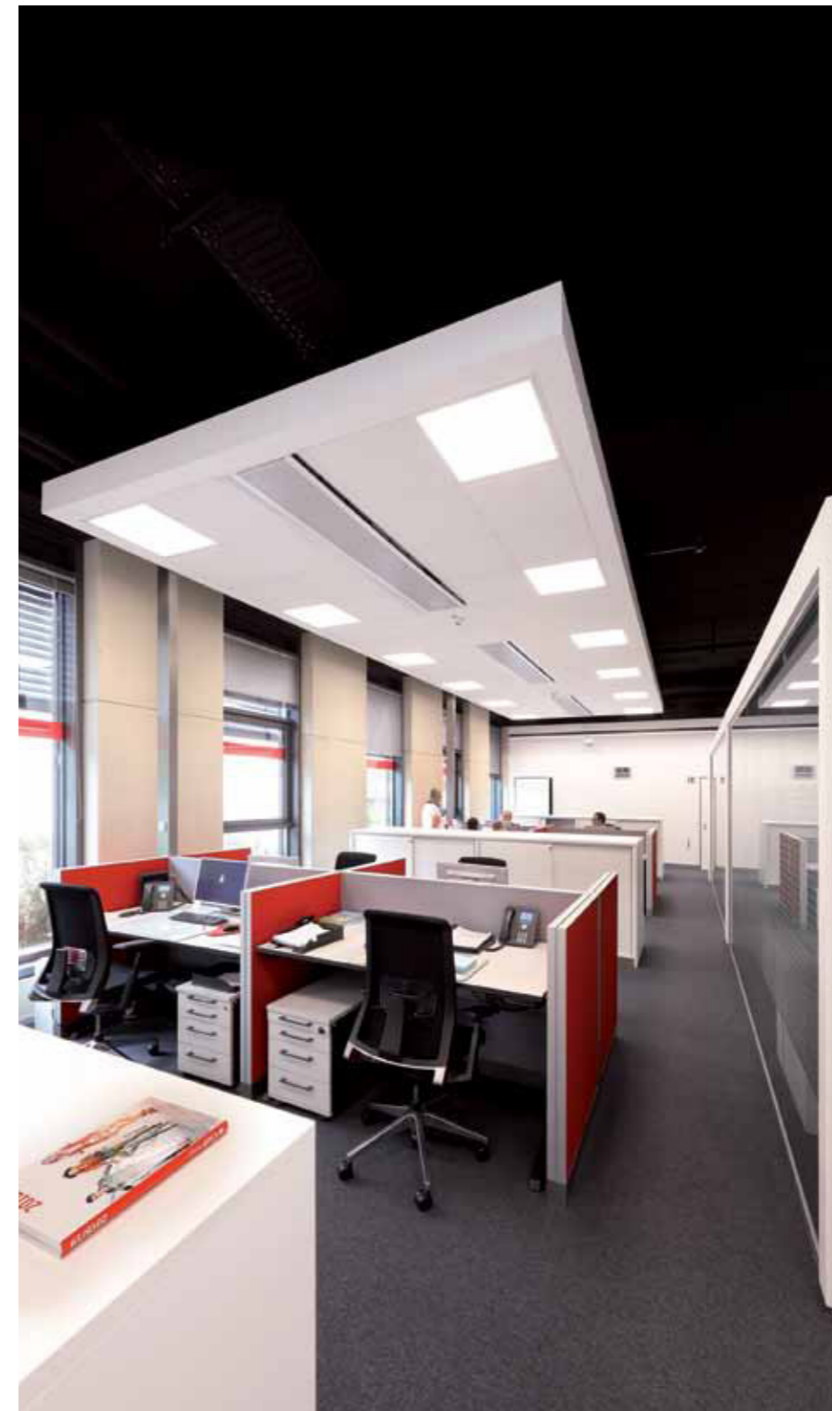
▲ Die Deckensegel reduzieren den raumbildenden Ausbau und damit die Baukosten
