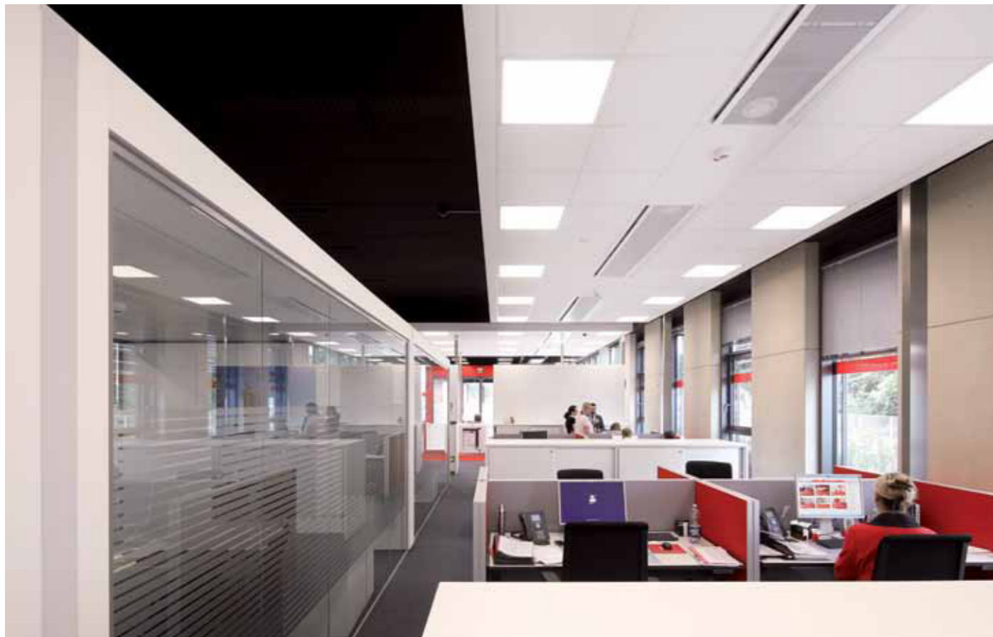
▲ Deckensegel für Licht und Lüftung sind nur da platziert, wo diese auch gebraucht werden
