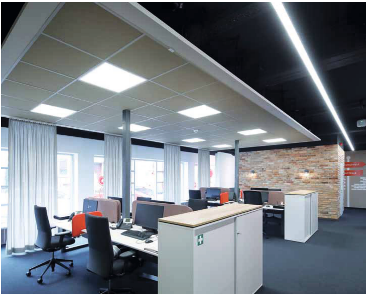
▲ Der offene Teambereich erhält durch ein abgehangenes Deckensegel sein Quartier. Die ELT- und Netzwerk-Versorgung ist über die Decke flexibel gestaltet
