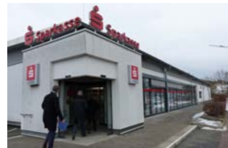
▲ Filiale Wetter vor dem Umbau
