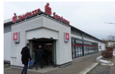
▲ Filiale Wetter vor dem Umbau
