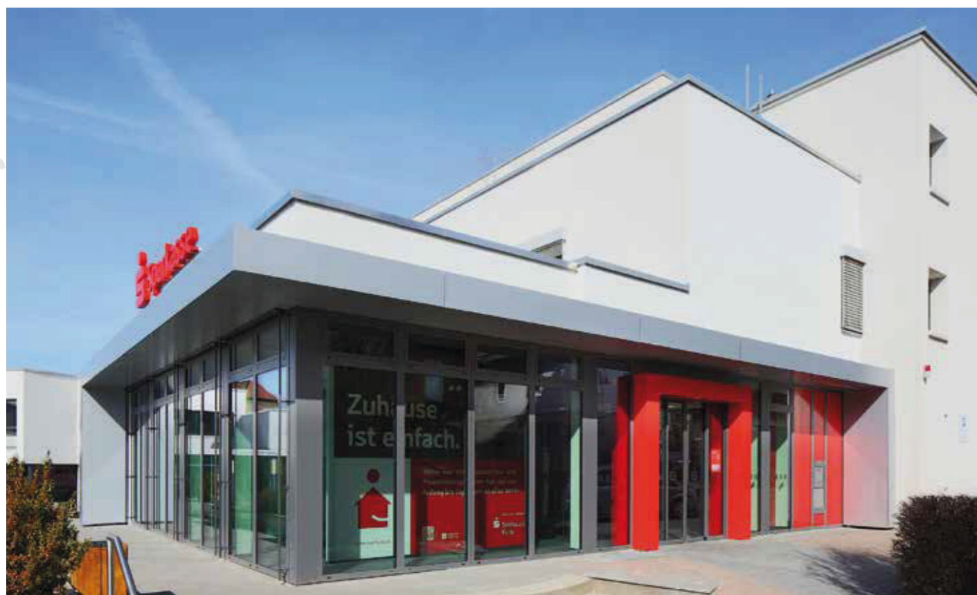
▲ Hilders - Der Neubau: Die Klammerbildung des Gebäudes schiebt die neue Fassade optisch in das Bestandsgebäude
