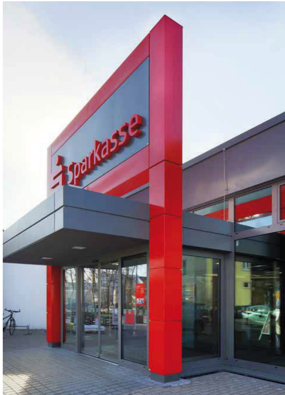
▲ Flieden - Das neue Eingangsportal in optischer Entsprechung zum roten Viadukt
