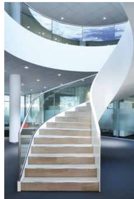
▲ Die neue Treppe ist aus Stahl gebaut
