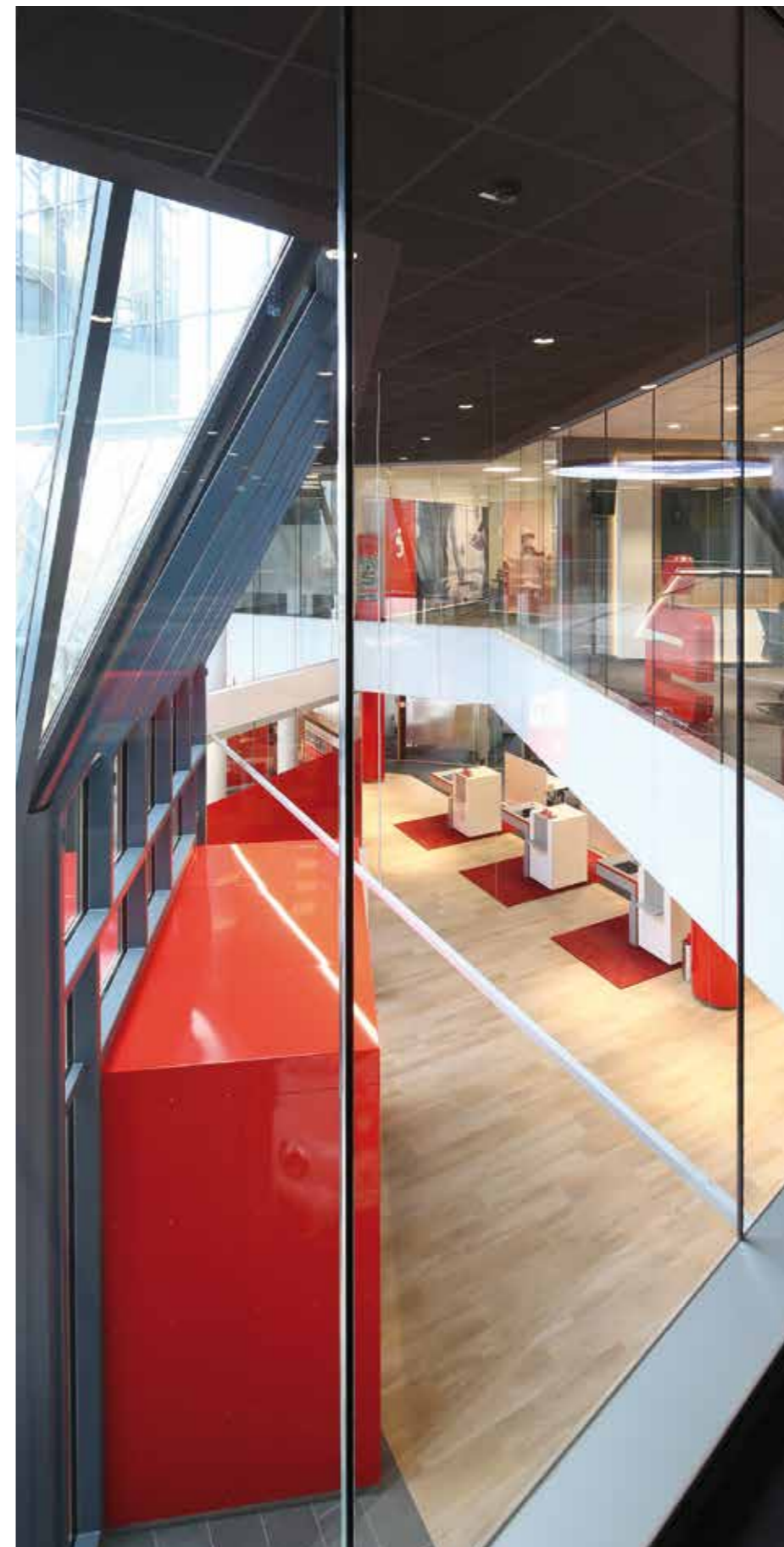
▲ Die raumhohe Verglasung im Obergeschoss verläuft hinterlackiert über dem Deckenaufbau und trennt den Luftraum zum SB-Bereich ab
