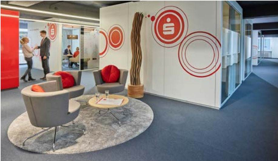
▲ Das Raum-in-Raum-System der Beratungsräume ermöglicht Änderungen von Größe und Platzierung
